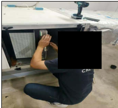
รูปที่ 2-29 (ต่อ) กิจกรรมทำความสะอาดเครื่องปรับอากาศ
