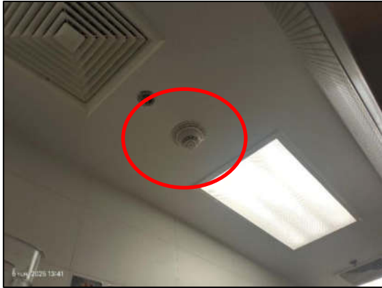
รูปที่ 2-56 เครื่องตรวจจับควัน
