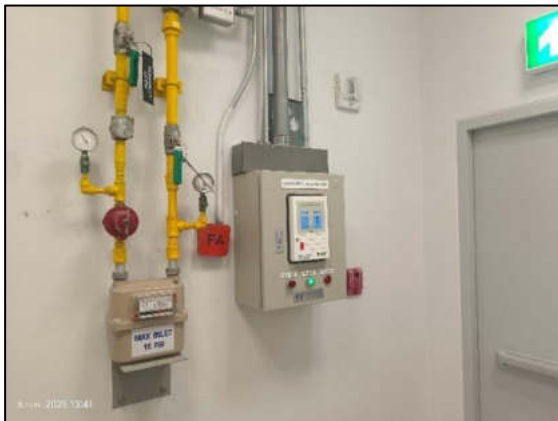
รูปที่ 2-57 เครื่องตรวจจับแก๊ส
