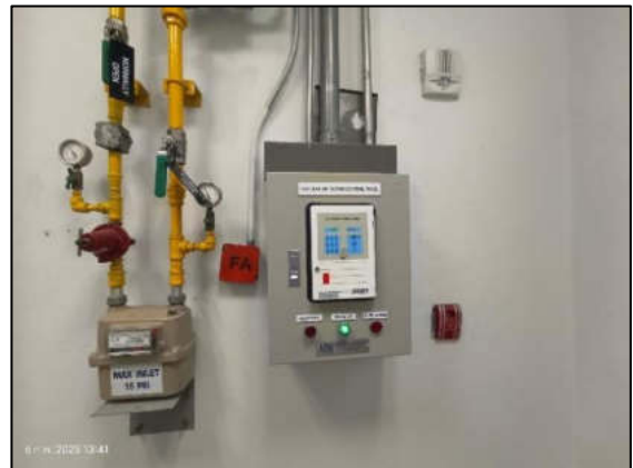
รูปที่ 2-57 เครื่องตรวจจับแก๊ส
