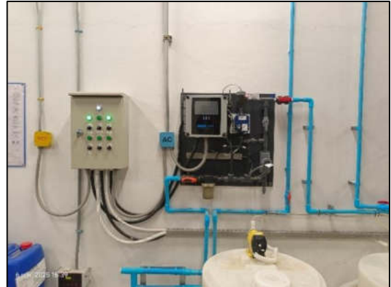
รูปที่ 2-44 ระบบบำบัดน้ำที่ระบายทิ้งจากท่อระบายความร้อน (Bleed off)
