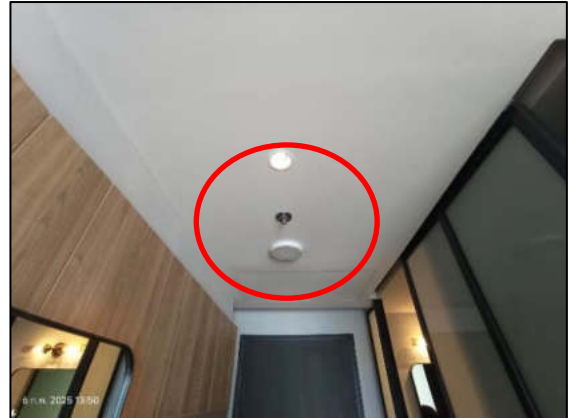
รูปที่ 2-49 หัวกระจายน้ำดับเพลิง
