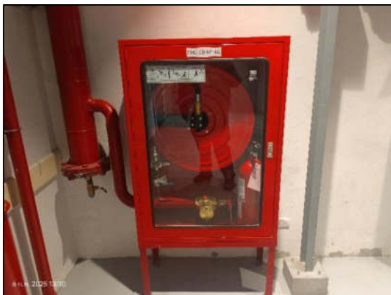
รูปที่ 2-48 ตู้เก็บสายฉีดน้ำดับเพลิง
