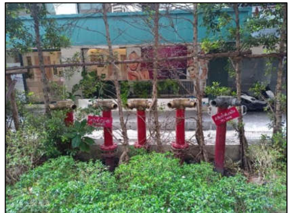
รูปที่ 2-47 หัวรับน้ำดับเพลิงภายนอกอาคาร
