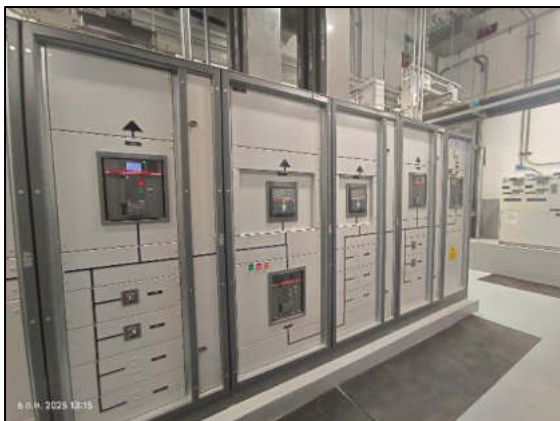
รูปที่ 2-8 ชุด Power Monitoring ที่ตู้ MDB
