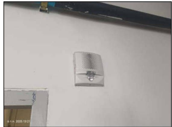
รูปที่ 2-54 อุปกรณ์ส่งสัญญาณแจ้งเหตุ
