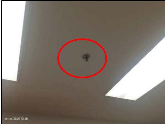
รูปที่ 2-49 หัวกระจายน้ำดับเพลิง
