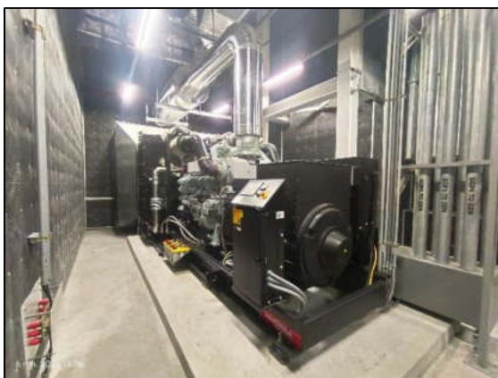
รูปที่ 2-18 ระบบจ่ายพลังงานไฟฟ้าสำรอง
