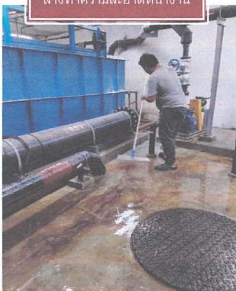
บ่อ FOG TANK (หลังทำให้แห้ง) ล้างทำความสะอาดหน้างาน
