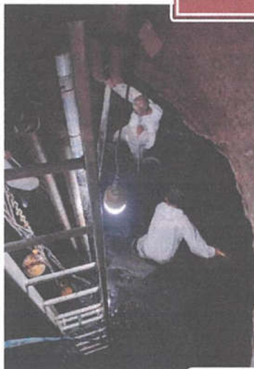
บ่อ FOG TANK (ขณะกำลังทำ) สูดน้ำที่ฉีดล้างออก
