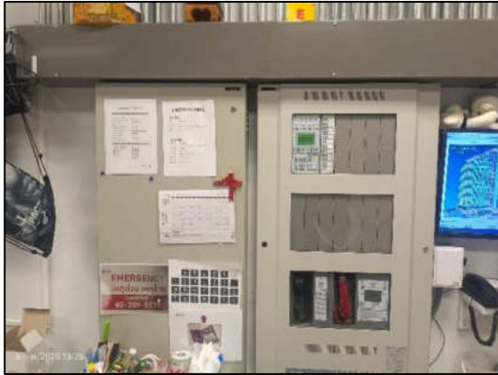
รูปที่ 2-52 แผงควบคุม (FCP)
