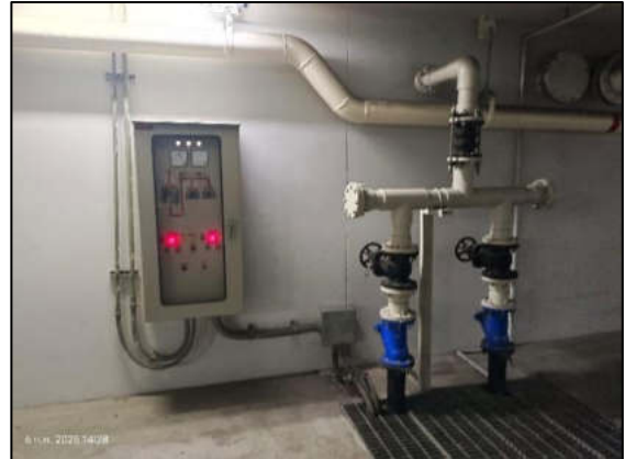
รูปที่ 2-15 ระบบบำบัดน้ำเสียชนิดเติมอากาศ (อาคาร M2)
