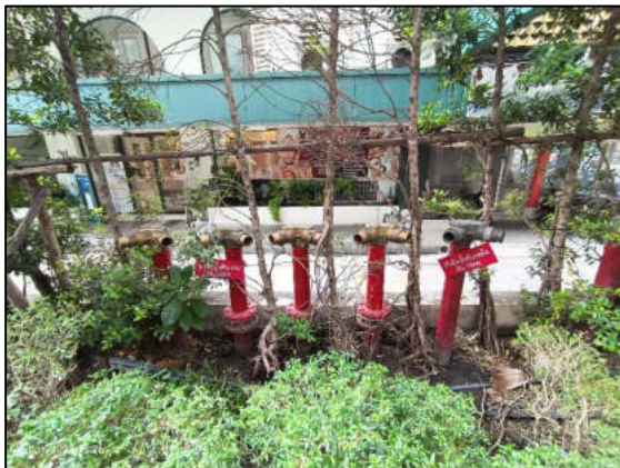
รูปที่ 2-47 หัวรับน้ำดับเพลิงภายนอกอาคาร
