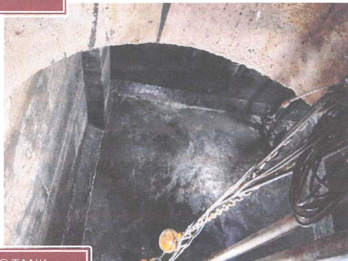
บ่อ FOG TANK (หลังทำให้แห้ง) ล้างทำความสะอาดหน้างาน
