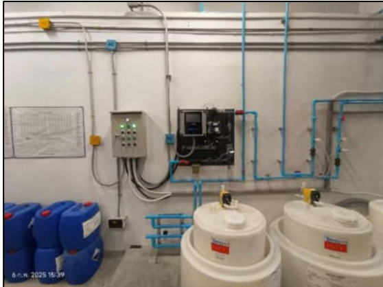
รูปที่ 2-44 ระบบบำบัดน้ำที่ระบายทิ้งจากท่อระบายความร้อน (Bleed off)
